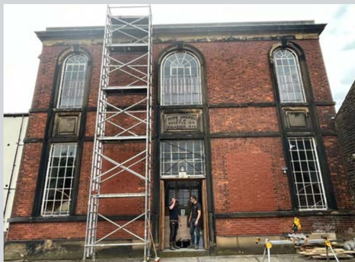
Herstel ramen en luiken voorgevel
